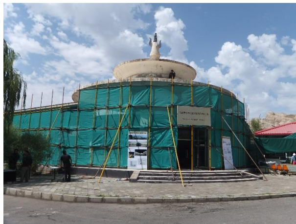
計画に沿って建設中の建物
